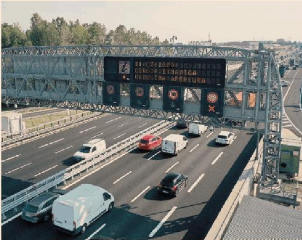
Tratto urbano della A4. L'autostrada Torino-Trieste nei pressi di Cormano (Mi)
