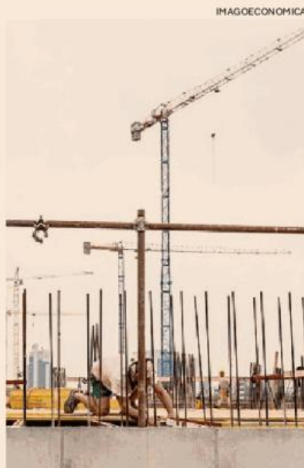
I cantieri. Un patto per il Pnrr
