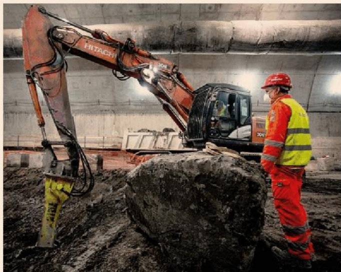
Alta velocità Genova-Milano. Lavori di scavo nelle gallerie del Terzo valico dei Giovi
