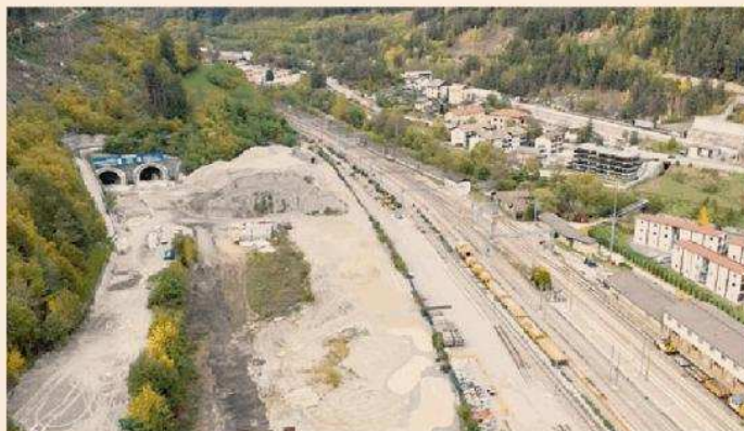
Tra Italia e Austria. Vista aerea del lotto H71 sottoattraversamento fiume Isarco
