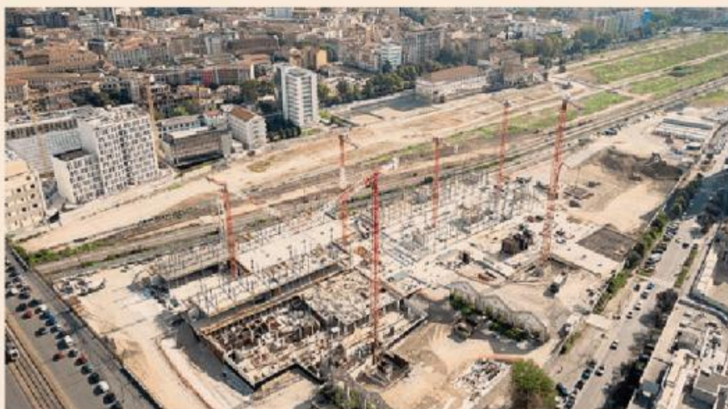
Villaggio Olimpico. Il cantiere appena avviato all'ex scalo di Porta Romana
