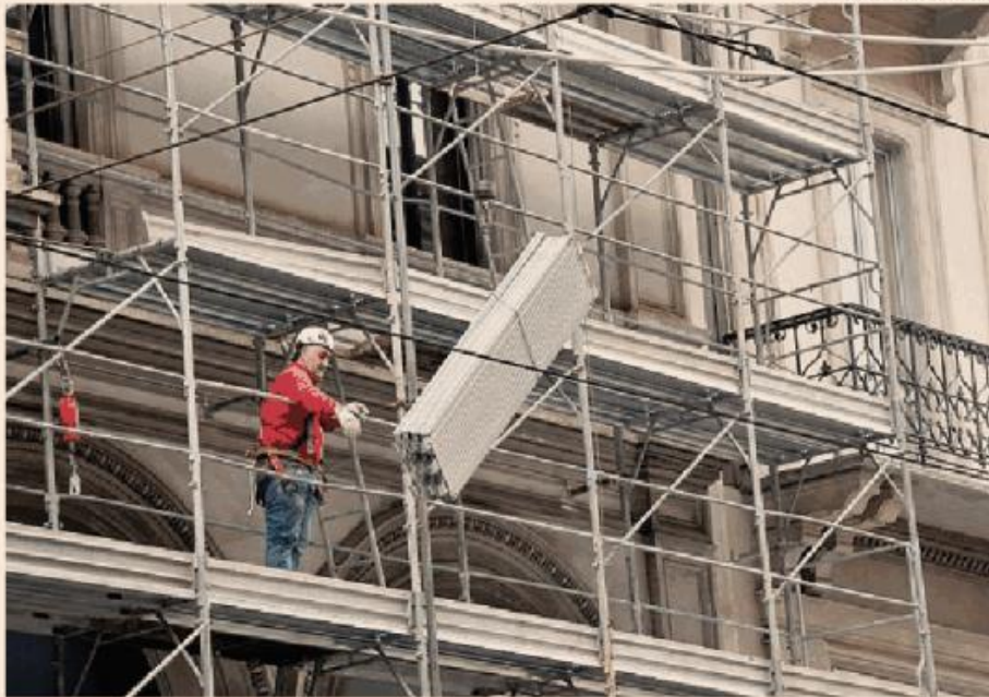
Lavori in corso. Per il superbonus in condominio si profilano tre mesi in più
