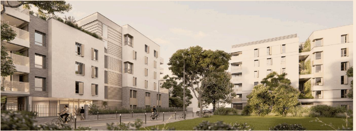
Fuori Parigi. Recygénie, il primo complesso immobiliare costruito interamente con calcestruzzo riciclato al 100%, sarà completato entro il 2024
