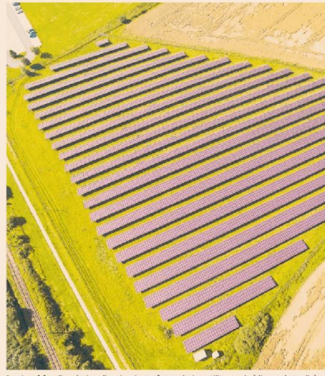
In stand-by. Rendering di un impianto fotovoltaico utility-scale (di grande taglia)
