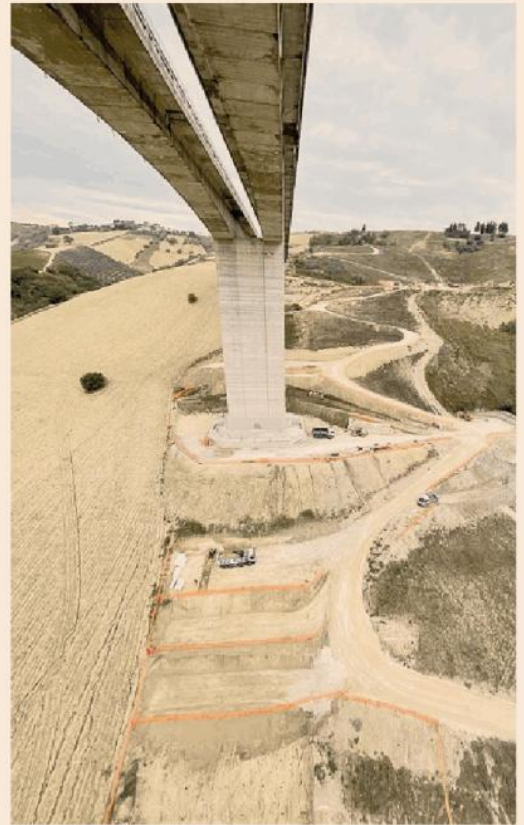
Ieri e oggi. Due immagini simbolo dell'autostrada Adriatica Bologna-Taranto (A14): a sinistra, i lavori di costruzione della tratta emiliana (giugno 1967); a destra: opere di consolidamento geotecnico sotto il viadotto Cerrano, nel tratto abruzzese della A14
