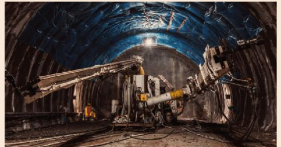
Sotto le Alpi. Due immagini degli scavi attualmente in corso tra Italia e Austria per la costruzione del tunnel ferroviario del Brennero: collegherà Fortezza a Innsbruck
