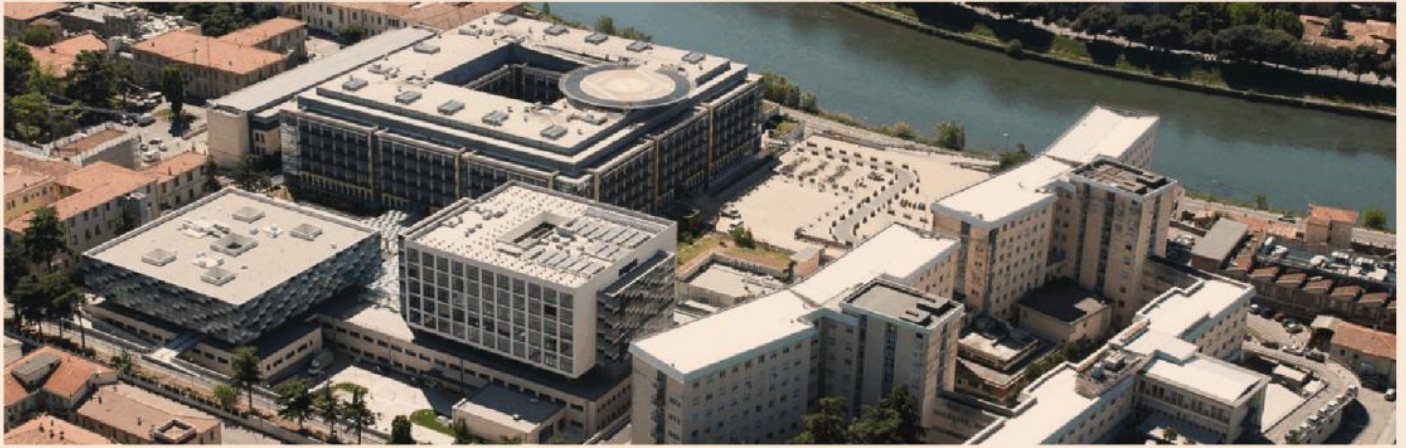
A Verona. L'ospedale di Borgo Trento che insieme a quello di Borgo Roma è stato realizzato dal Cmb di Modena con un Pf a 20 anni e per un costo complessivo di 126 milioni
