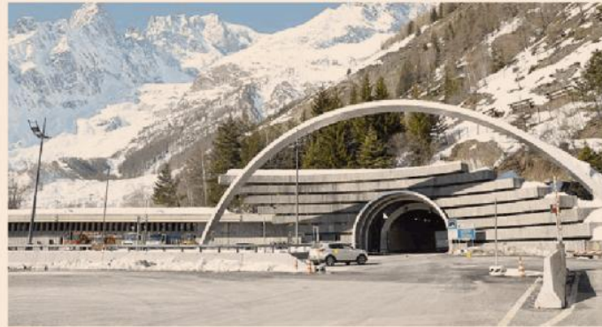
L'imbocco. L'ingresso del tunnel dove transitano 600mila mezzi pesanti all'anno
