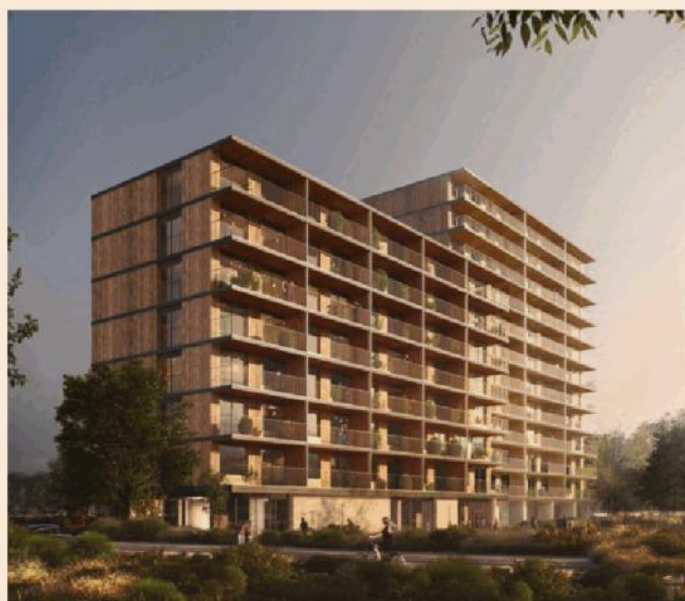
Paesi Bassi. Il complesso di Rotterdam Valckensteijn su fondamenta preesistenti
