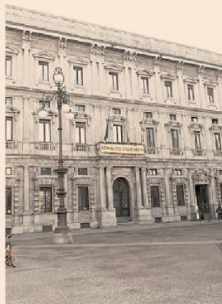
Palazzo Marino. Sede del Comune di Milano
