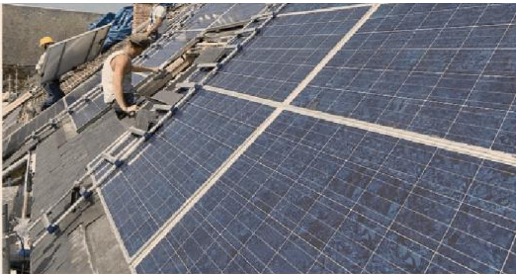
Energia dai tetti. Posa di pannelli fotovoltaici
