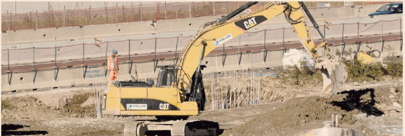
Il cantiere infinito. Un tratto della Pedemontana, l'autostrada lombarda di 67 chilometri che aspetta da decenni di essere completata
