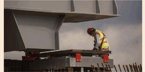
Alta velocità. Alcuni momenti delle attività di preparazione al varo di un viadotto nel cantiere del primo lotto della Napoli-Bari (Napoli-Cancello)
