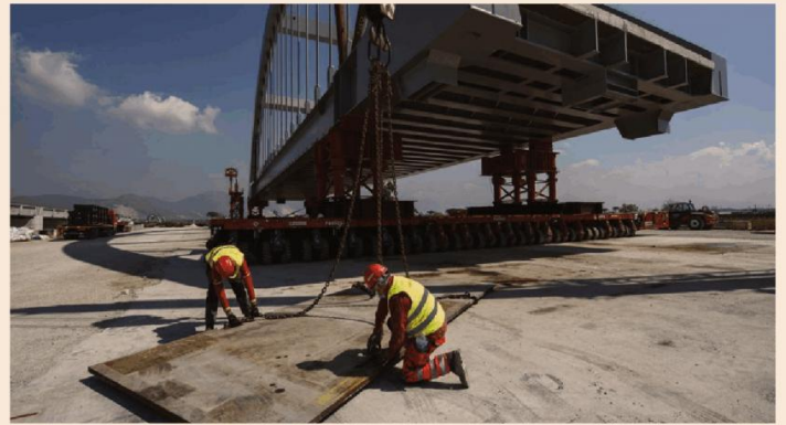
Alta velocità. Alcuni momenti delle attività di preparazione al varo di un viadotto nel cantiere del primo lotto della Napoli-Bari (Napoli-Cancello)
