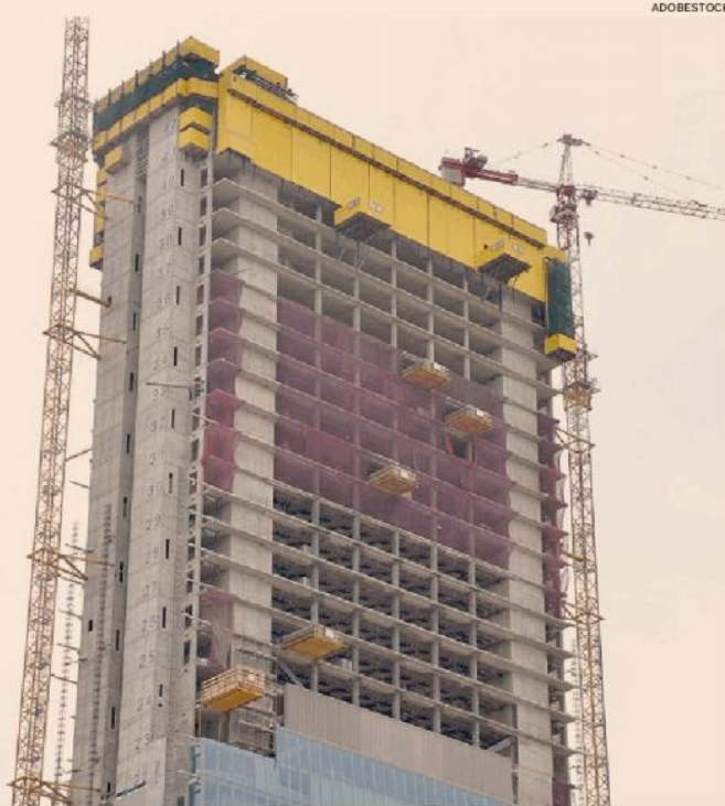
Fase iniziale. La costruzione di torre Isozaki, oggi sede di Allianz, a Citylife, a Milano
