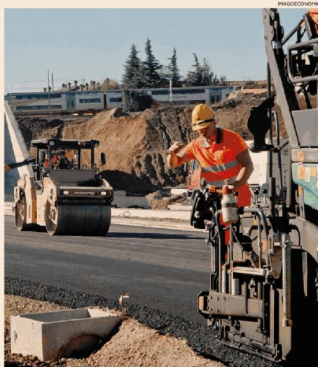
Cantieri. Per la Commissione Ue quella degli appalti è una riforma chiave
