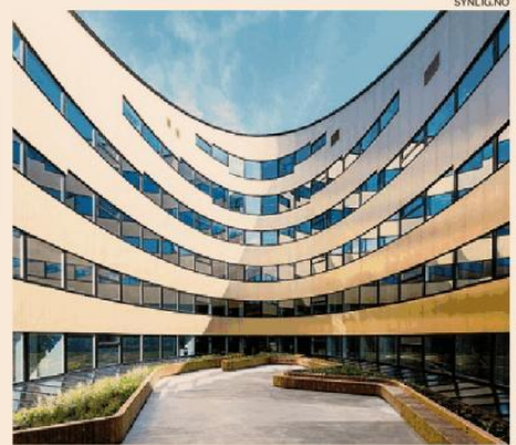
Powerhouse Brattørkaia (Trondheim, Norvegia). L'edificio produce più energia di quanta ne consuma
