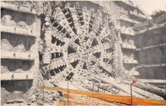
Autostrade/1. Nella foto sopra: ingegnere Tecne (Asp) al lavoro in un cantiere lungo la rete; a sinistra: la fresa Tbm in azione. La nuova galleria Santa Lucia (A1) è stata scavata con l'ausilio della fresa Tbm più grande d'Europa
