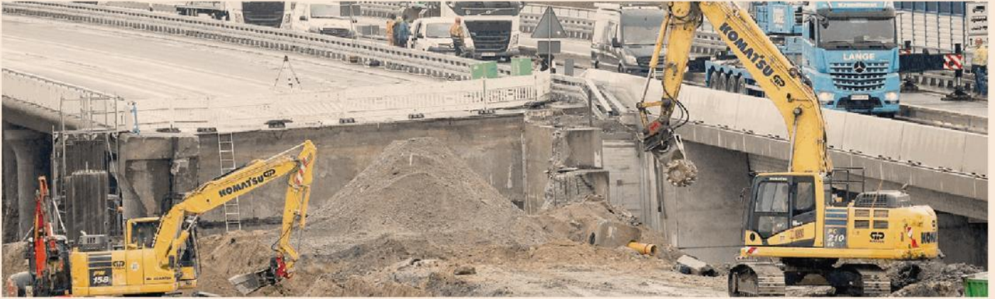
Paracadute antirincari. Per il 2022 lo scudo vale anche per i lavori dei general contractor delle opere in corso del gruppo Fs e Anas
