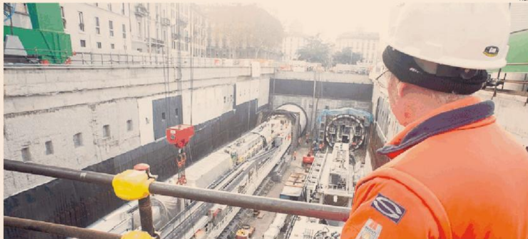
Grandi infrastrutture urbane. Una veduta dei cantieri per la realizzazione della linea 4 della metropolitana di Milano
