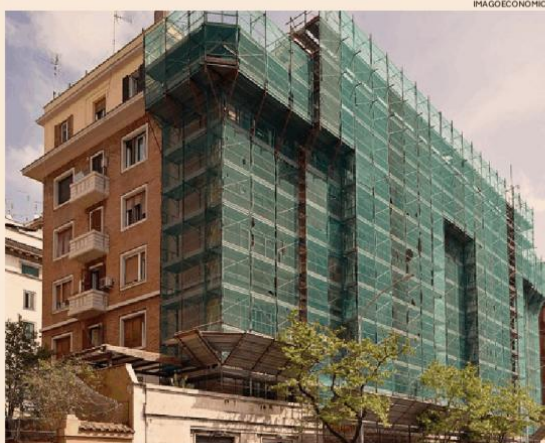
Lavori in corso. Il restauro della facciata di un condominio a Roma
