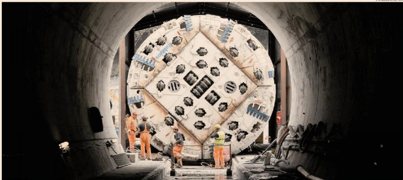
Grandi lavori. Una veduta del cantiere per la realizzazione del tunnel per la linea ferroviaria ad alta velocità tra Torino e Lione
