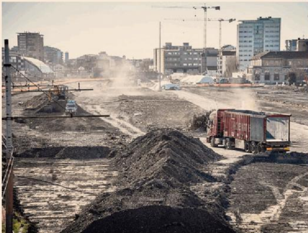
Cantieri aperti. La costruzione del villaggio olimpico a Milano
