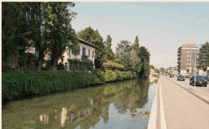
Via Bottego. Uno degli immobili acquistati da Casacash a Milano
