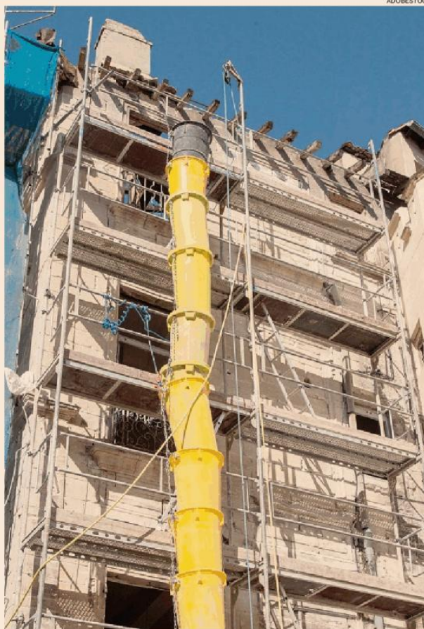
Riqualificazioni. Il super bonus apre anche ad abbattimenti e ricostruzioni
