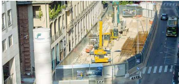
La battaglia legale Il cantiere del box interrati in via Borgogna è contestato da un comitato di residenti e imprenditori (foto Alberico)
