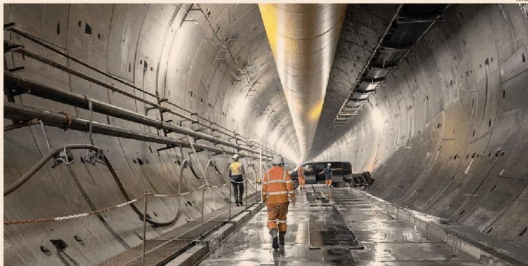
Infrastrutture strategiche. Una veduta dei lavori in galleria per il collegamento alta velocità tra Torino e Lione
