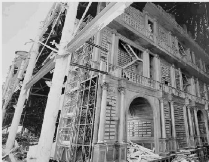
Ex Area Expo. Smantellamento degli edifici esistenti in cantiere
