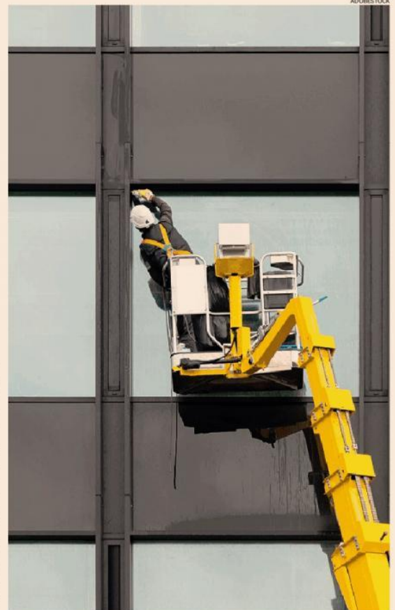
Manutenzione. Molte strutture sono state sottoposte a interventi straordinari
