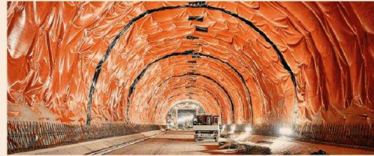
Tra Italia e Austria. Il cantiere della nuova galleria ferroviaria di base del Brennero, in costruzione tra Innsbruck e Fortezza
