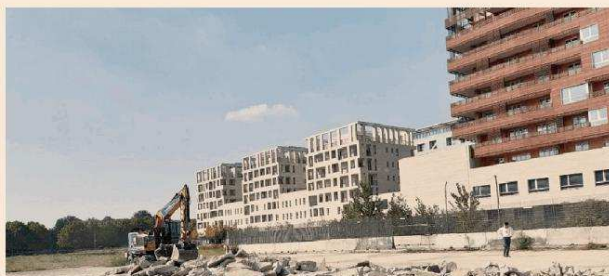
Porta Vittoria. Il complesso a Milano, in primo piano il cantiere per i lavori relativi al parco che Prelios ha appena avviato
