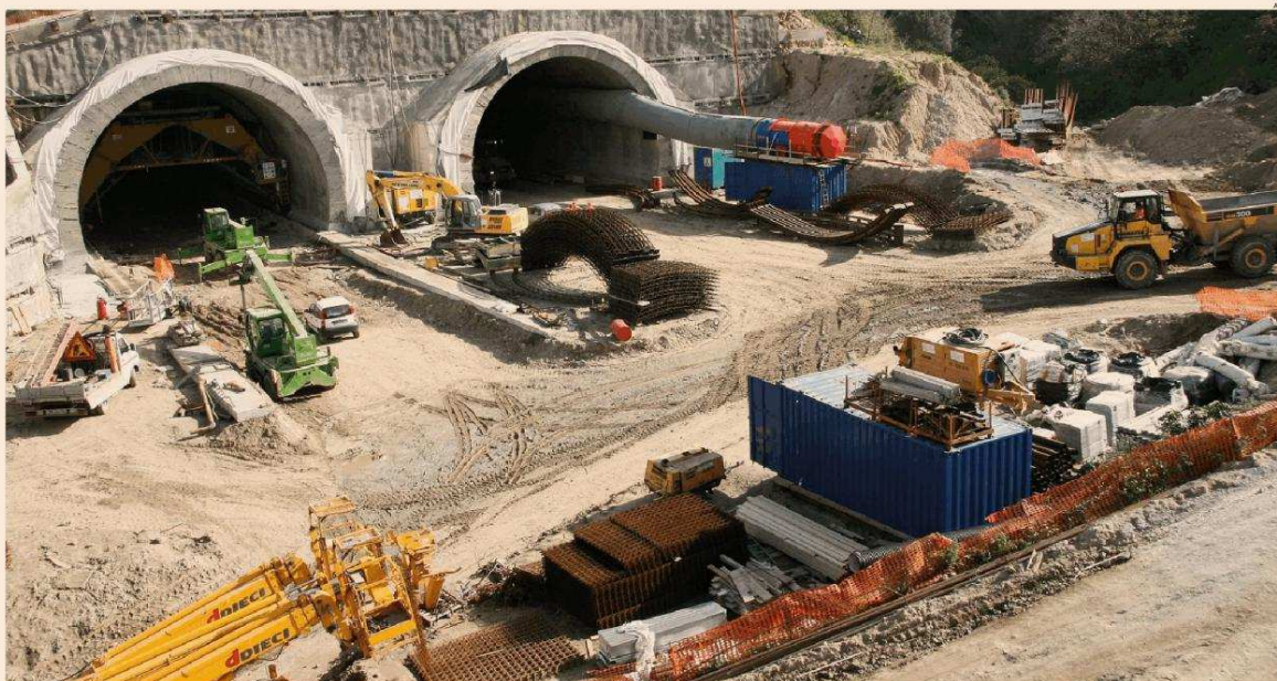
Fuori dal tunnel. Lavori di adeguamento e ammodernamento delle gallerie dell'Autostrada Salerno-Reggio Calabria, oggi A2. La Salerno-Reggio Calabria, oggi completata dopo molti anni di lavori sul percorso, è stata a lungo il simbolo dell'arretratezza del sistema autostradale italiano e della lentezza dei lavori di adeguamento
