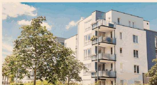
Su misura. Un condominio isolato con il sistema Sigmasol, che permette l'assemblaggio di strati diversi a seconda delle caratteristiche del muro da coprire
