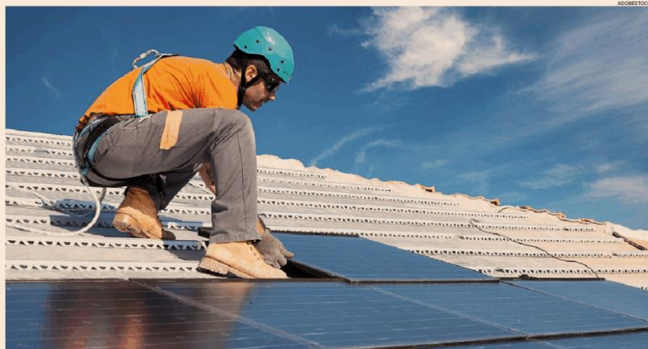
Lavori «al traino». L'installazione di pannelli fotovoltaici è un intervento abbinabile al superbonus sia nella versione "eco" sia in quella sismabonus
