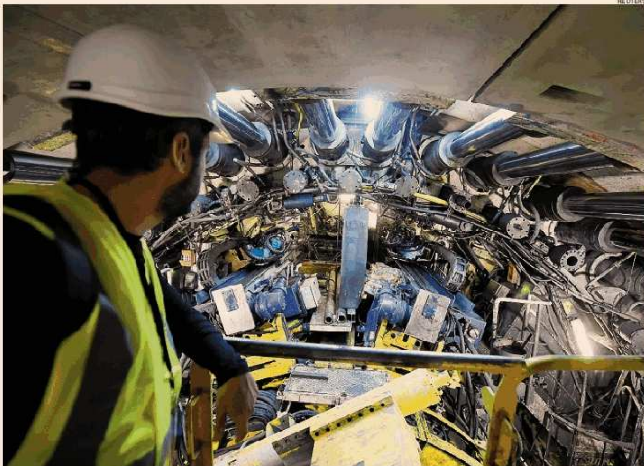
I lavori della Tav. Il cantiere della Torino-Lione
