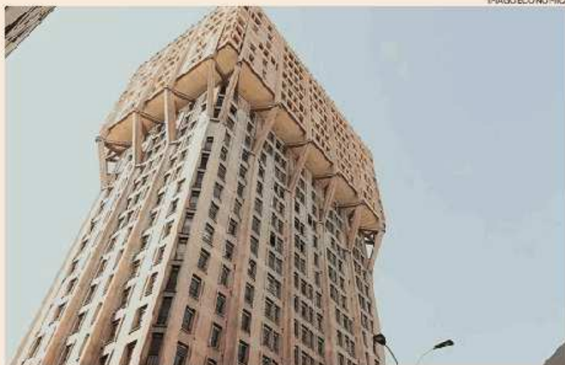
Edificio iconico. La Torre Velasca a Milano
