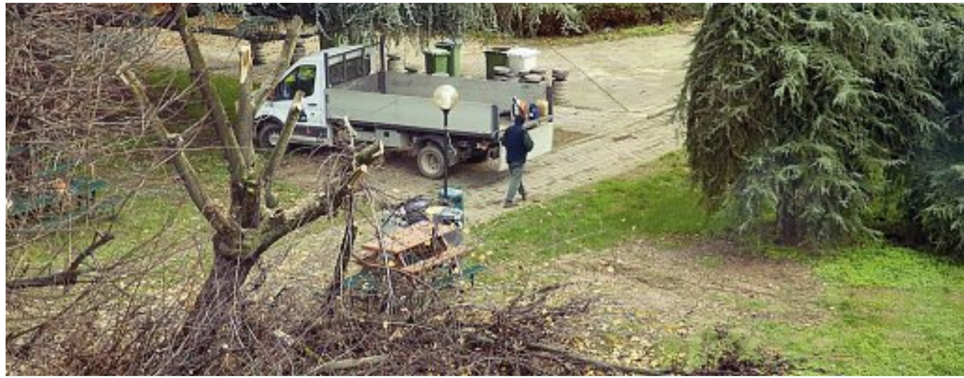
Cantieri Il taglio delle prime piante nell'area verde di via Bassini. I lavori sono stati bloccati ieri e oggi, in attesa degli esiti della commissione comunale (Fotogramma)
