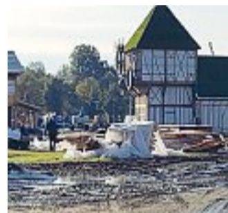
Sopralluogo Il Villaggio in costruzione
