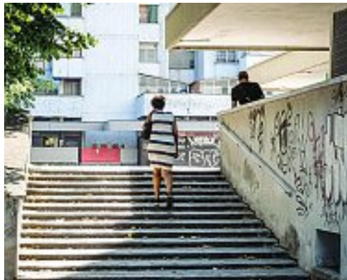
Periferia Sud I gradini per accedere alla cosiddetta «piazza senza nome» sotto alle torri bianche (Corner)
