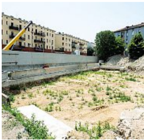
Ruspe Via Lorenteggio 181, demolito due anni fa (foto Bozzo)
