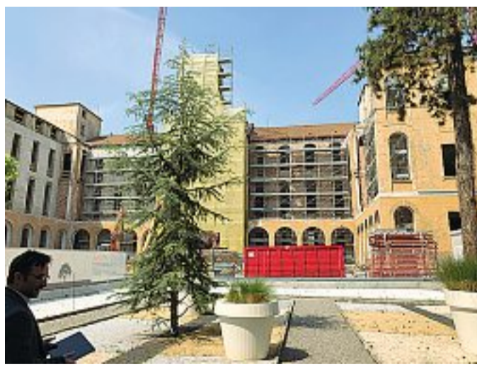
Gli alberi Il cantiere oggi con i lavori di ristrutturazione su edificio storico e verde
