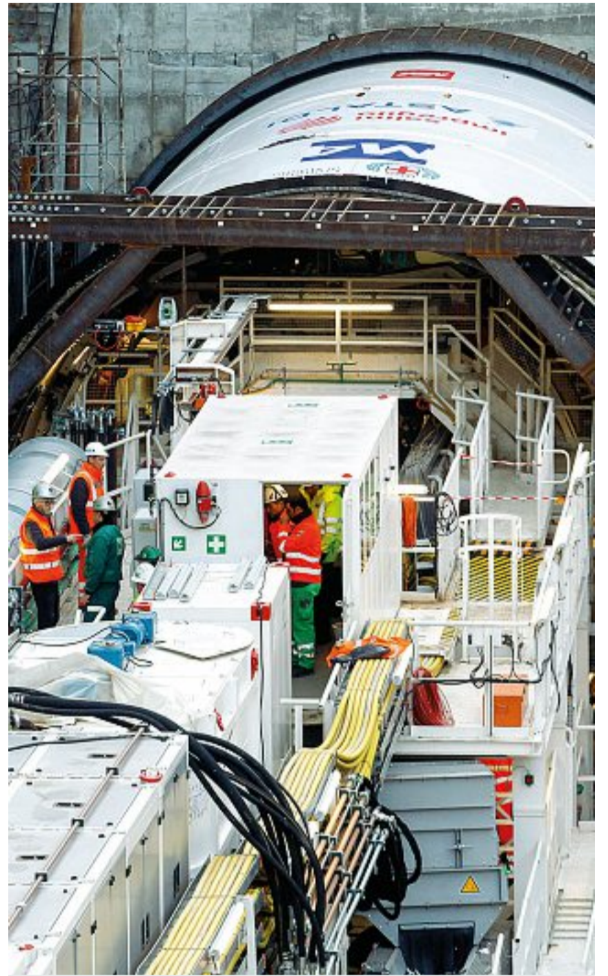
Operativa A 20 metri di profondità, la tunnel boring machine assemblata in Germania arriva nel cuore della città dopo aver finito di scavare i primi 8 chilometri del tracciato da Linate a piazza Tricolore
