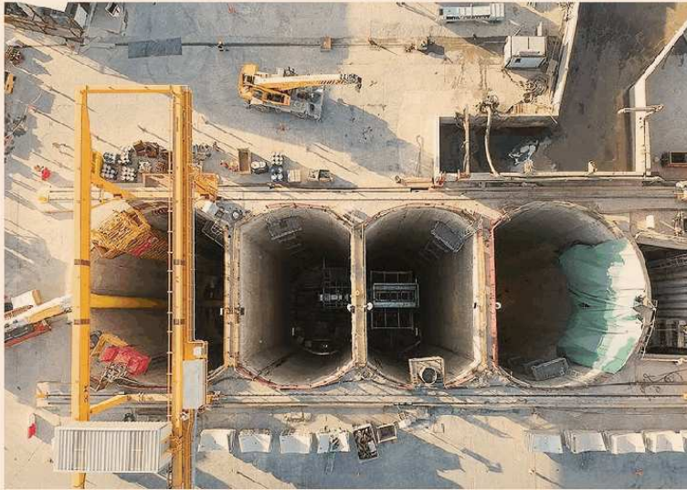
Argentina Il cantiere Salini Impregilo a Buenos Aires per il tunnel idraulico destinato al risanamento del fiume Riachuelo
