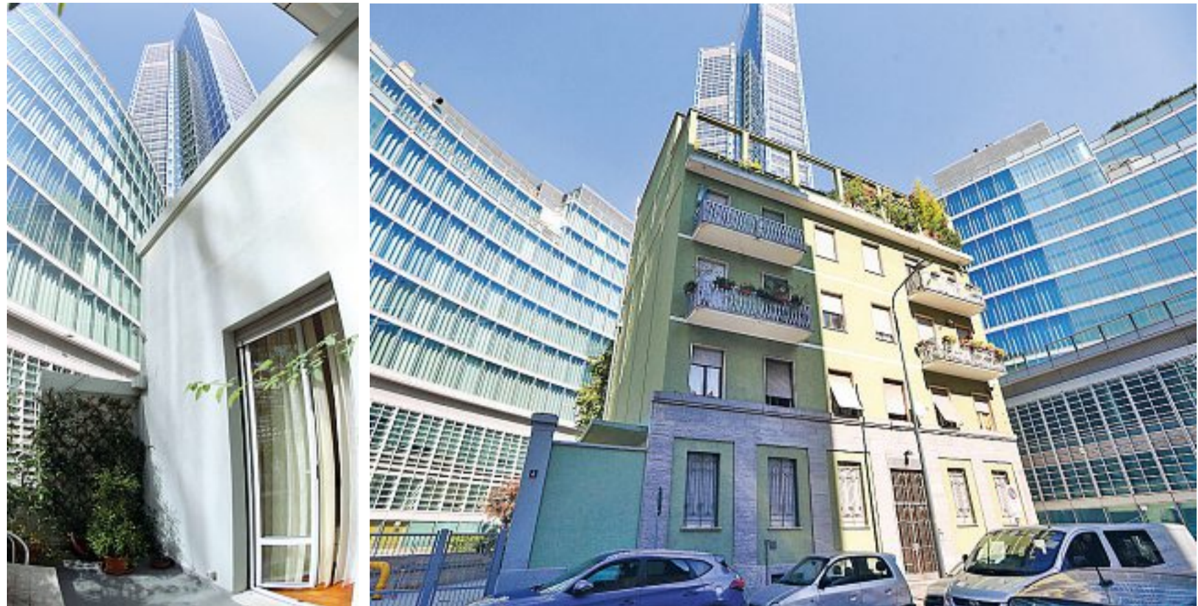
Circondato L'edificio di via Bellani 3 con alle spalle il Palazzo della Regione Lombardia (foto Porta/LaPresse). Nell'area sono aperti i cantieri per la costruzione di parcheggi e nuovi fabbricati
