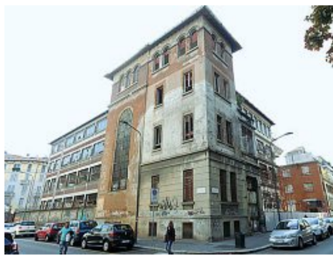
Presente Il cantiere per demolizioni e bonifiche è iniziato il mese scorso (Porta)
