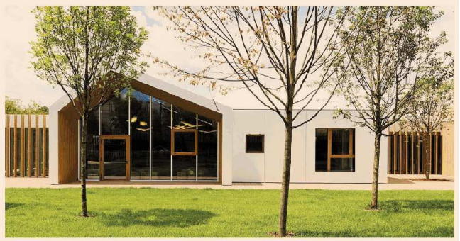
Qui Milano. A CityLife il "BabyLife", un asilo nido completamente in legno, progettato dallo studio o2Arch
