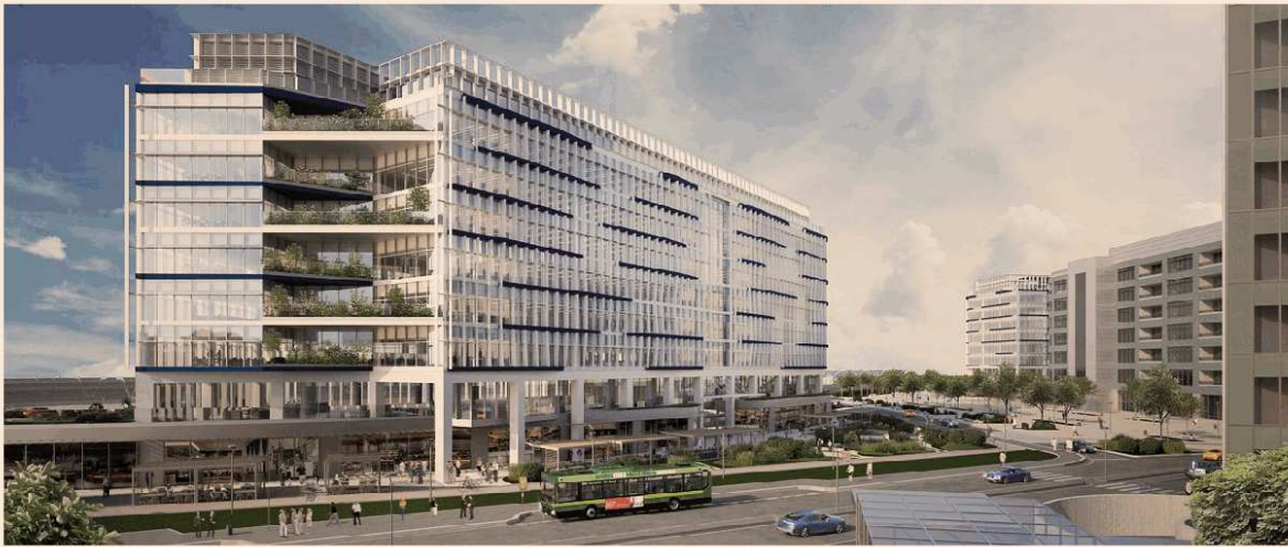
Milano Rogoredo Sorgerà nel quartiere Santa Giulia Spark One (nella foto). Accanto si innalzerà Spark 2. Il progetto è firmato dallo studio Cmr. Sarà così completato il nuovo business district, su cui già sorge lo Sky Campus.
